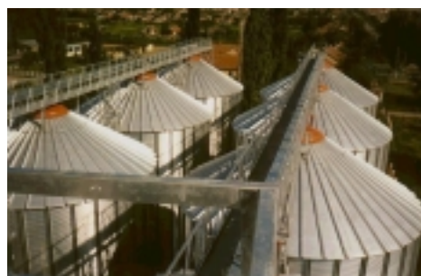
Рис.2.40. Силосные корпуса из оцинкованной стали
